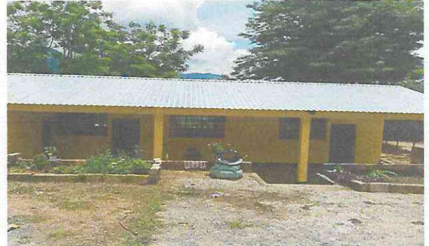
Foto 4: Cambio de techo y pintura de paredes en aulas
