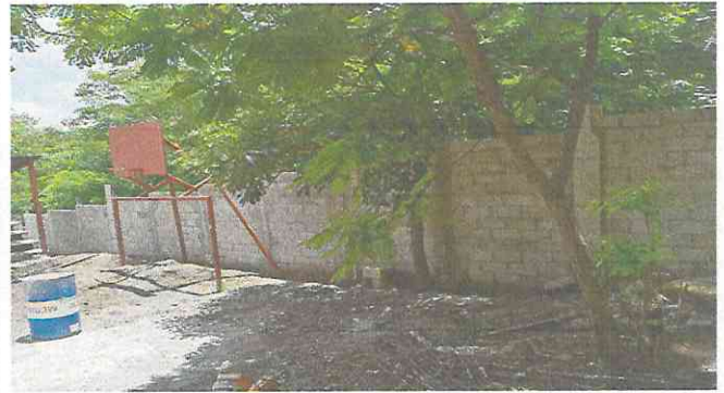
Foto 2: Levantado de muro perimetral
