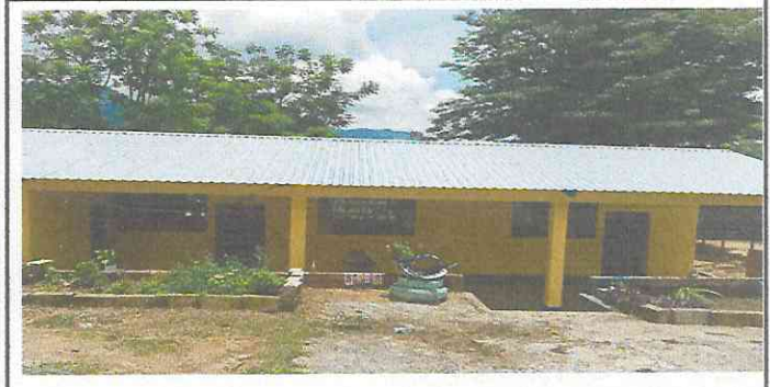
Foto 6: Pintura en exterior de aulas
