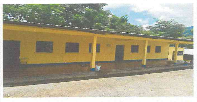
Foto 6: Pintura en exterior de aulas
