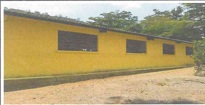
Foto 5: Pintura de exterior de aulas
