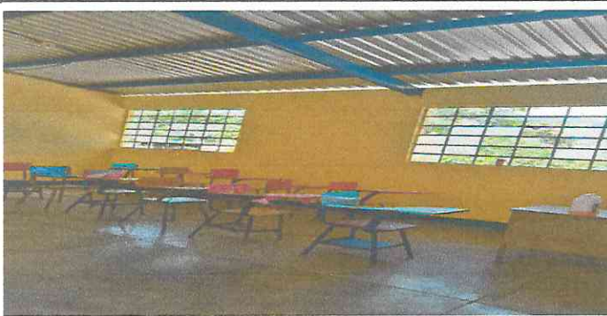
Foto 3: Pintura de estructura metalica de aulas
