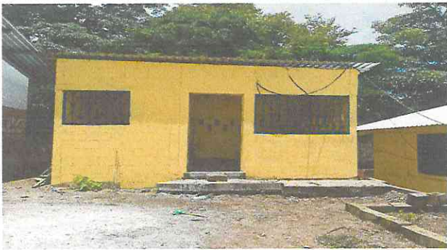
Foto 5: Ampliación de cocina
