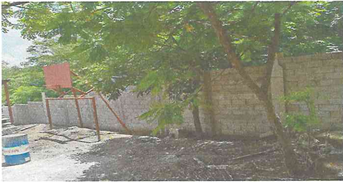
Foto 3: Levantado de muro perimetral
