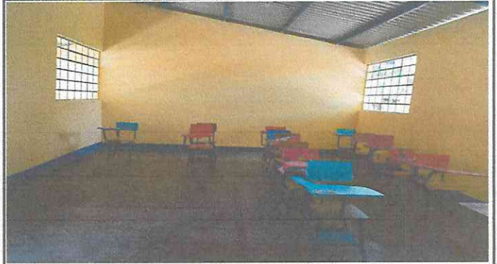
Foto 2: Pintura en interior de aulas
