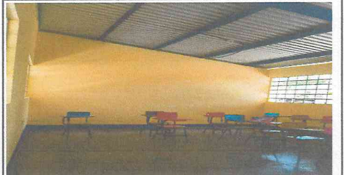
Foto 4: Pintura de estructura metalica en aulas
